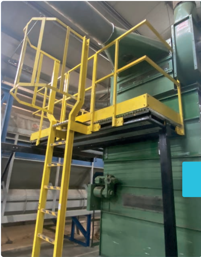
Les travaux sur le site d'Ecotechnolin de Saint-Martin-du-Tilleul.
